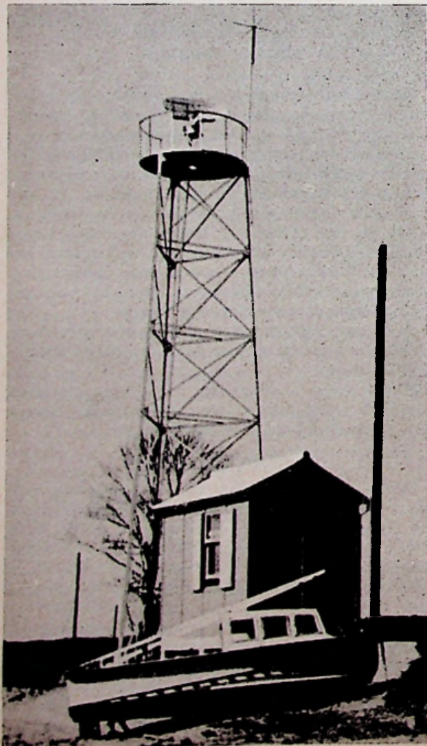
Foto 1. — Zicht op de cabine waarin de experimentele radarinstallatie is ondergebracht, op de toren en de antennes.
